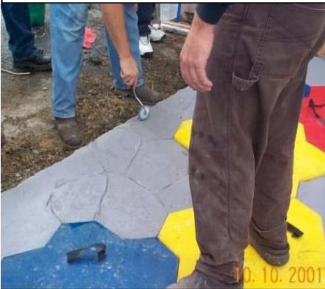
Béton Imprimé Sols
